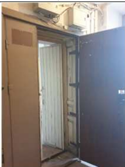
Вход в пом. 35-Н
