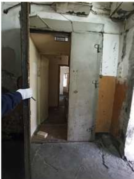
Вход в пом. 19-Н
