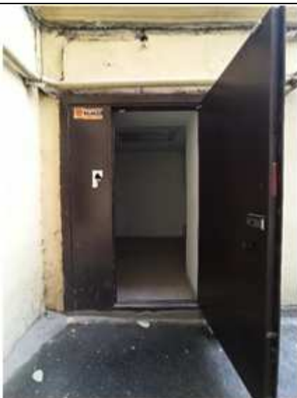
Вход в пом. 14-Н
