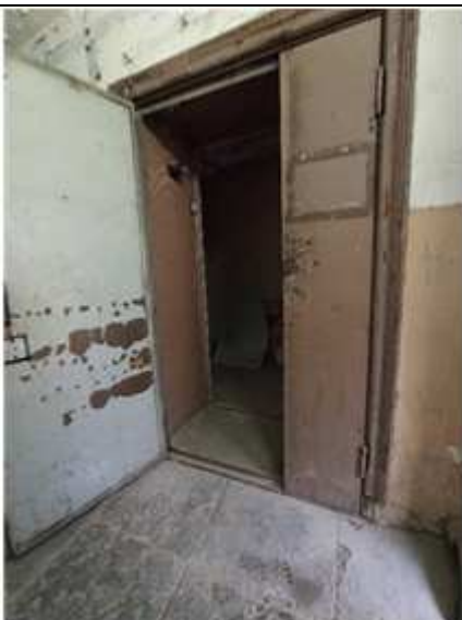
Вход в пом. 17-Н
