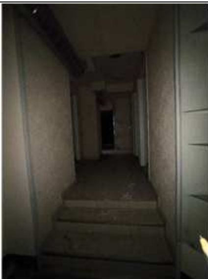
Вход в пом. 16-Н через пом. 15-Н
