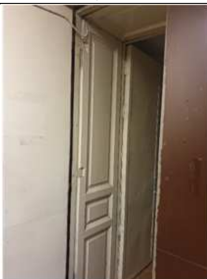
Вход в пом. 44-Н
