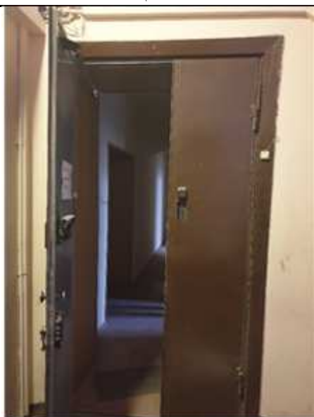
Вход в пом. 48-Н
