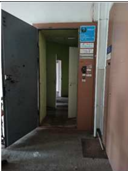
Вход в пом. 74-Н
