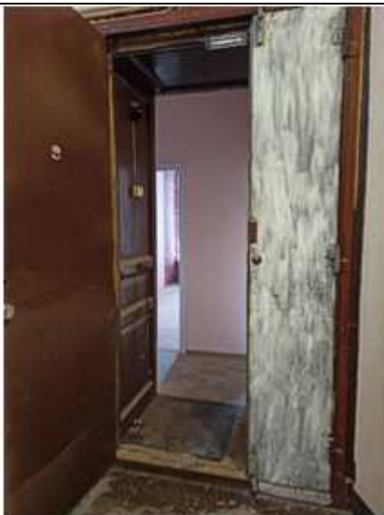
Вход в пом. 37-Н
