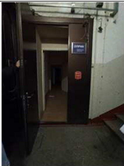
Вход в пом. 33-Н
