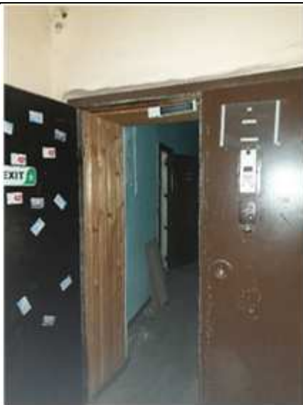
Вход в пом. 63-Н
